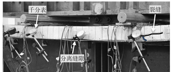
图 8 裂缝向交界面发展
