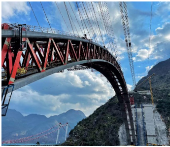
图 22 乌蒙山大桥主拱
