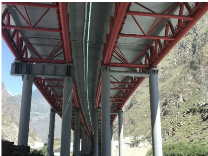
图 6 四川汶马高速汶川克枯大桥
