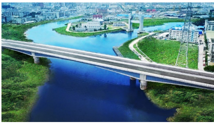
图 11 深圳东宝河新安大桥
