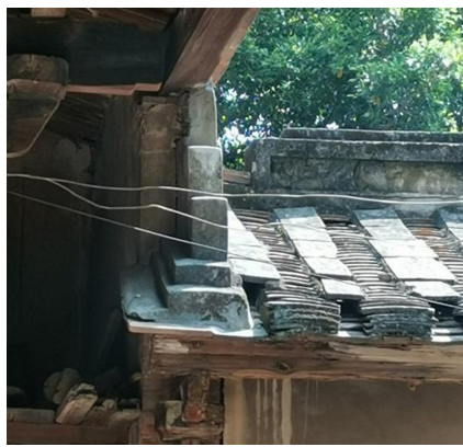
图 1 多层迭涩式雨埂墙
