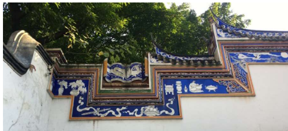
图1 门墙外壁墙顶、墙楣(局部)
