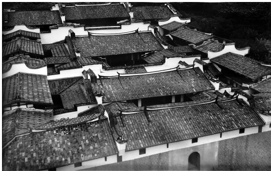
图 6 东关寨封火墙 Fig.6 Fireproof walls
