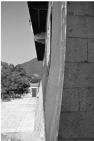
图 3 花岗岩墙体 Fig.3 Granite walls
