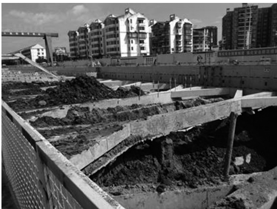
图 10 基坑开挖准备
