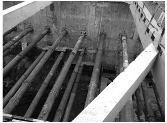
图 11 基坑开挖施工
