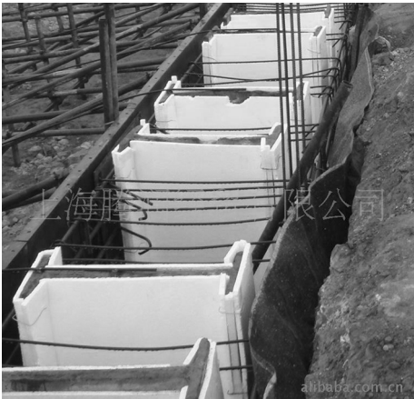
图 3 泡沫塑料包裹 H 型钢
